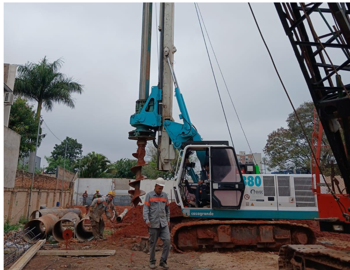
Trabajos de perforación y cargamento de pilotes
