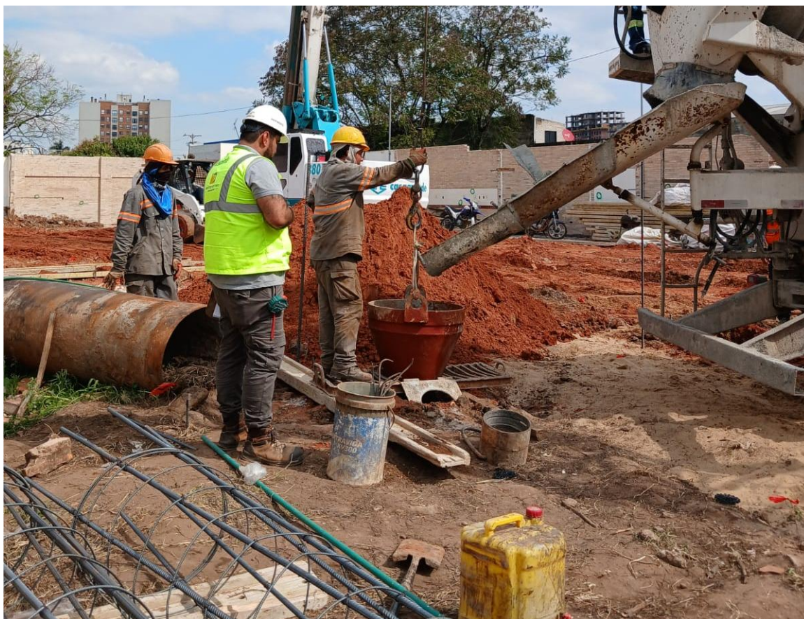
Trabajos de perforación y cargamento de pilotes
